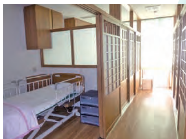
プライバシー保護のため、間仕切り工事をしました
