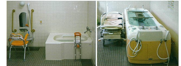
▲浴室 共同浴槽だけでなく、お一人で入浴できない方にはストレッチャーに寝たまま利用できるタイプの入浴設備も完備しております。
